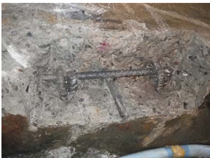
(4) フーチング (B 橋) の健全な鉄筋
