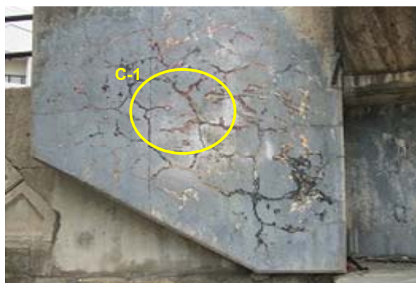
写真-3 事例 C の劣化状況およびコア採取位置（左：左岸上流側，右：左岸下流側）
