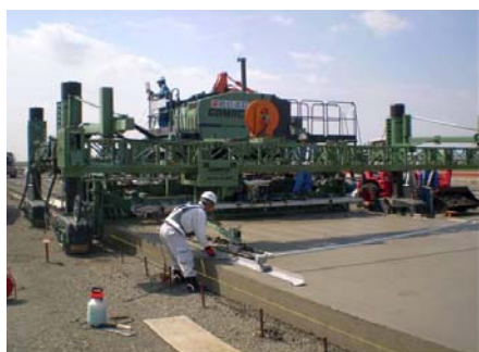
写真-1 舗装用スリップフォームの打設状況
