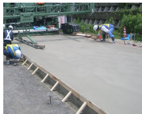
写真-5 配合1の施工状況
