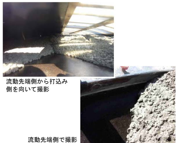
写真-4 増粘剤系中流動コンクリートの流動状況
