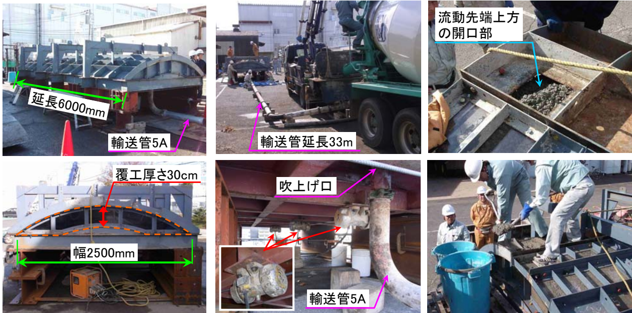
(a) 天端部模擬型枠の外観 (b) 型枠振動機，輸送管設置状況 (c) 流動先端の開口部と試料採取状況
