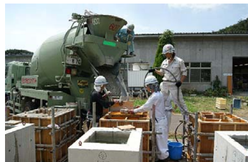
写真-2 桁形試験体打設の様子
