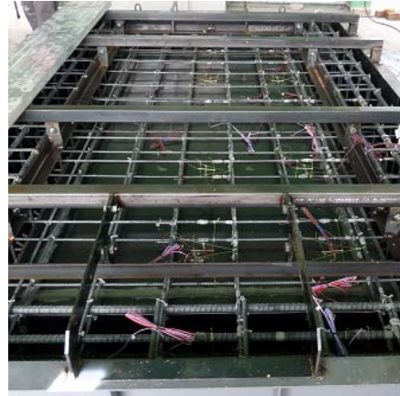
図-4 梁付スラブ配筋状況
