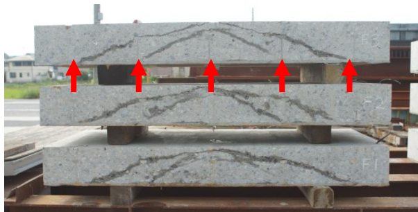
図-17 供試体切断状況 切断線① (上から I-300-F01, I-300-F02, I-300-F03, ↑リブ)
