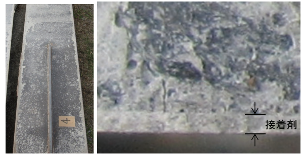
写真-3 剥離状況 (H-S-2 供試体)
