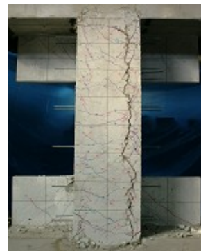
CW2 正面 (補強部)
