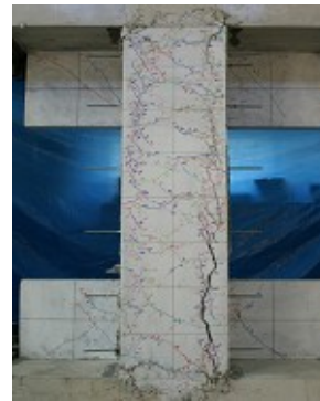
CW1 正面 (補強部)
