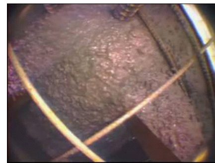
写真 - 4 打設状況 (100N, 圧入工法)
