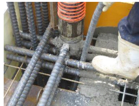
写真 - 1 打設状況 (80N, 柱頭部)
