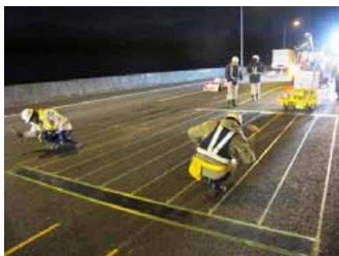
写真 - 5 はく離調査状況
