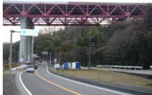
写真 - 1 調査対象橋梁
