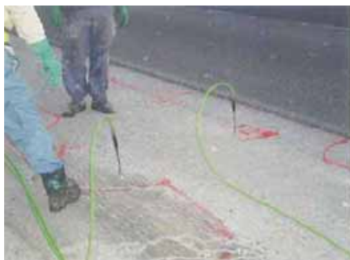
写真 - 2 樹脂注入状況
