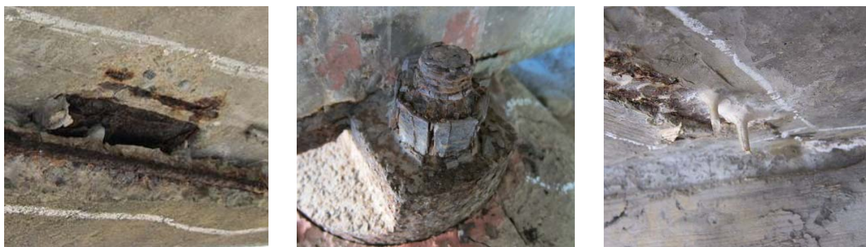
(b) 支承部の腐食
