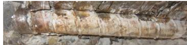
(a) グラウト状況
