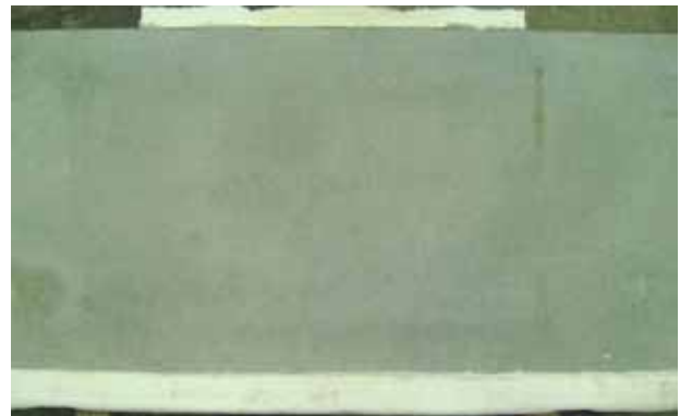
写真 - 6 a-2 試験体の加熱後状況 (400 加熱, PP 繊維未混入, 高強度コンクリート配合)
