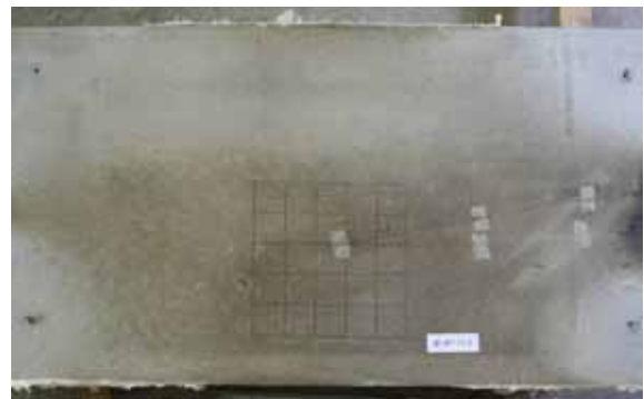
写真 - 4 耐火被覆板を除いた a-3 試験体の加熱後状況 (1200 加熱, PP 繊維未混入, 高強度コンクリート配合)
