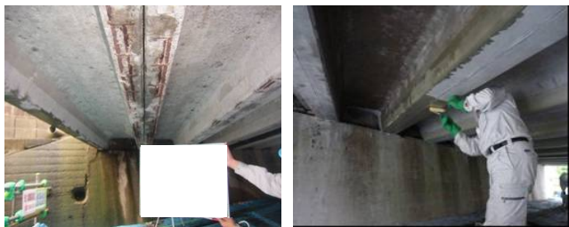
写真-2 B橋梁における表面含浸工法適応状況
