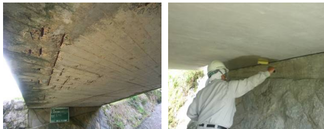
写真-1 A橋梁における表面含浸工法適応状況
