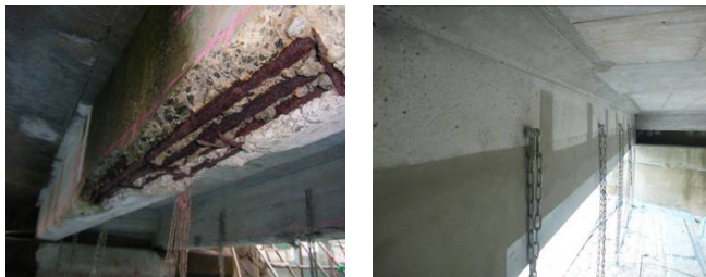
写真-3 C橋梁における表面含浸工法適応状況
