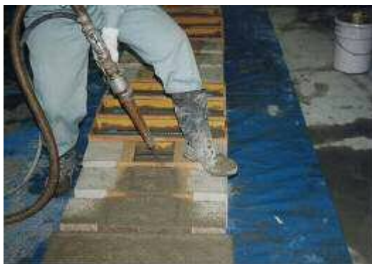
写真-1 断面修復施工状況
