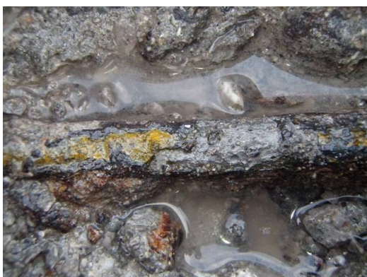
写真-2 はつりによる鉄筋の腐食状況確認
