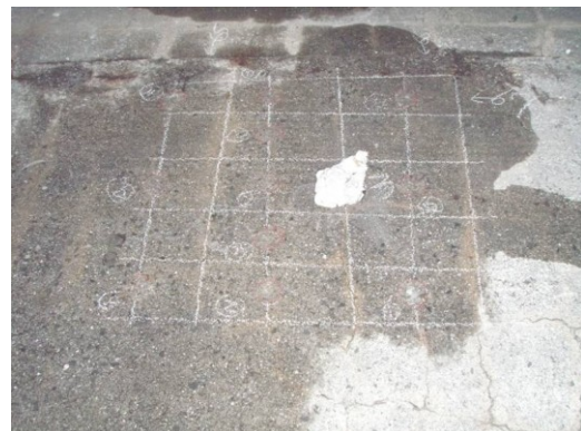
写真-1 棧橋の床版上面
