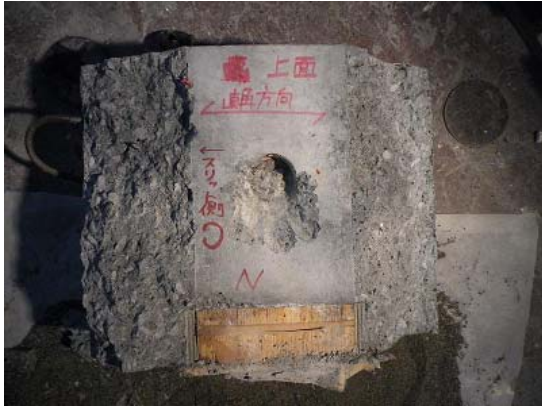
写真-2 パイプ下部コンクリートの圧縮破壊
