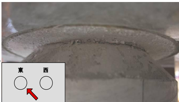
写真－1 圧縮側杭杭頭部
