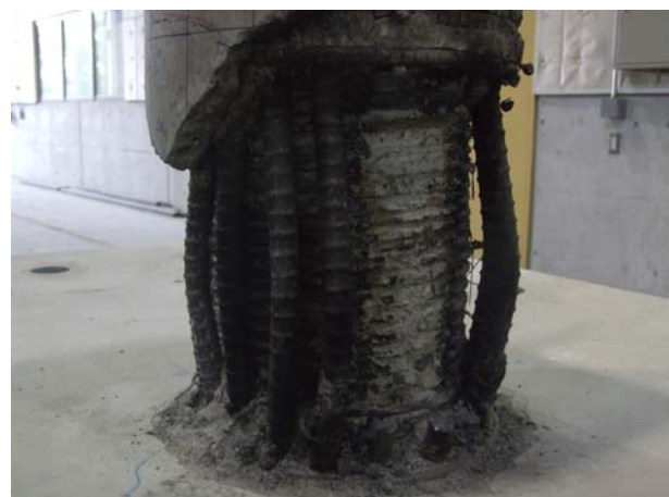
図-7 No.2 実験終了後のコアコンクリートの状況
