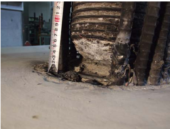
図-9 実験終了後のコアコンクリートの状況
