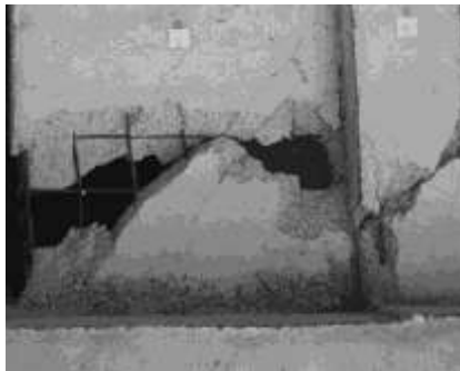
写真-1 低強度コンクリート試験体の
