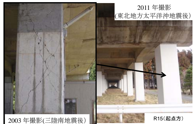
図四 東北新幹線第5猪鼻高架橋 (R15)
