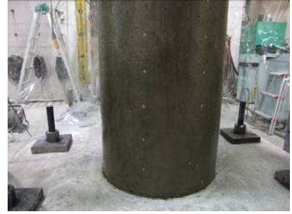
写真-7 補修後 (試験体 No. 3)
