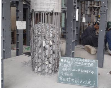
写真-6 補修前 (試験体 No. 3)
