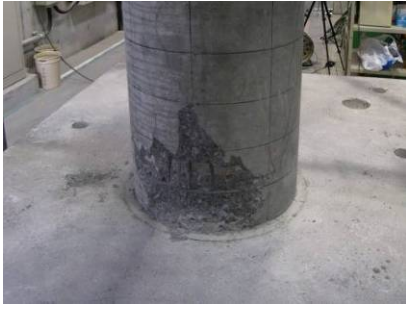
写真-2 損傷後 (試験体 No. 2)
