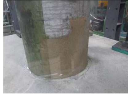
写真-4 補修後 (試験体 No. 2)
