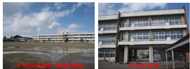
写真 2-1 校舎南側外観
