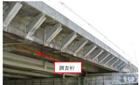
写真-3 撤去前の橋梁
