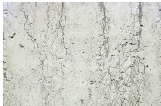
(1) 鉛直面に生じた砂すじ
