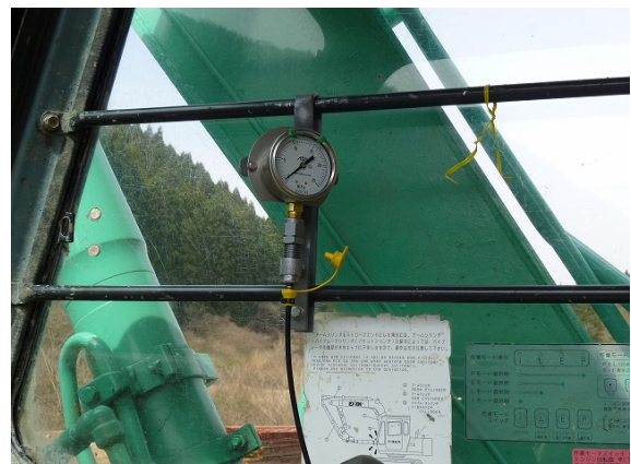
写真-2 油圧計設置状況（拡大）
