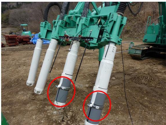
写真-3 環状電極の設置状況 (写真)
