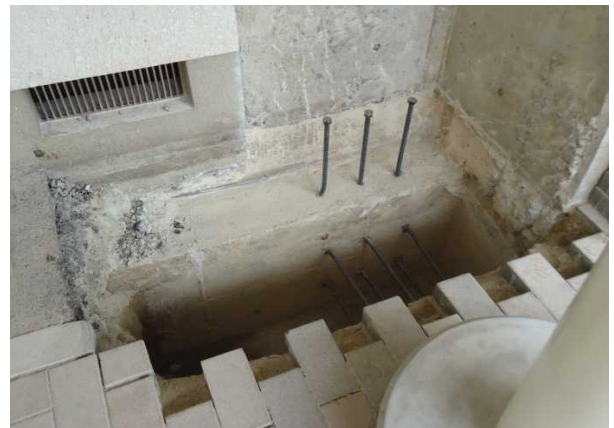
写真 - 1 ハツリ工事・アンカー打設
