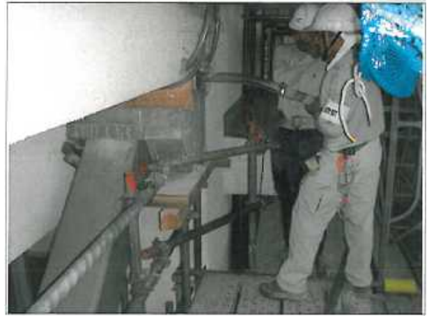
写真 - 8 グラウト注入
