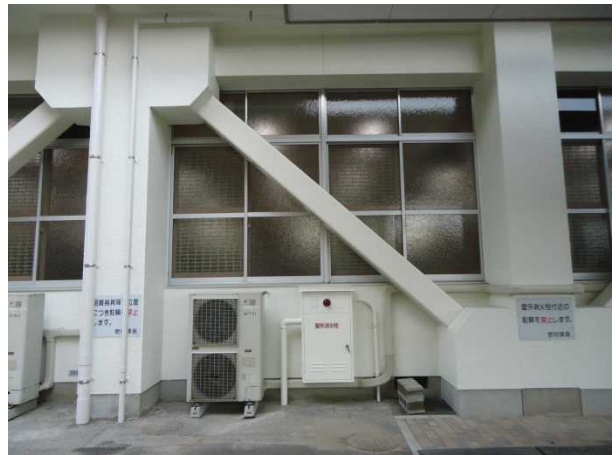
写真 - 9 工事完了後
