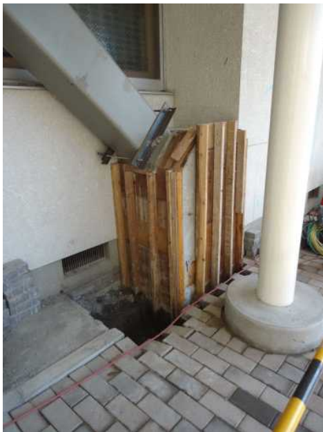
写真 - 6 型枠工事
