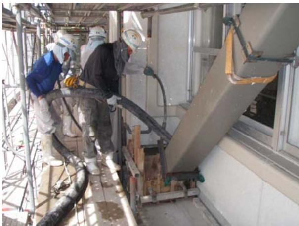
写真 - 7 コンクリート打設
