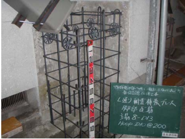
写真 - 5 配筋工事
