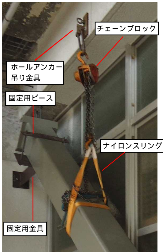
写真 - 2 吊り治具・固定具
