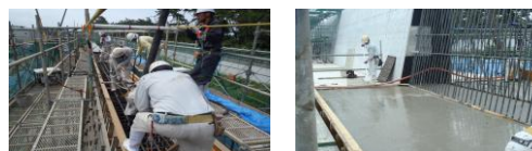
写真-2 打設状況
