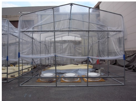
写真-4 開口部を設けたビニールハウス
