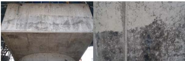
写真-1 コンクリート構造物に生じた色むら
