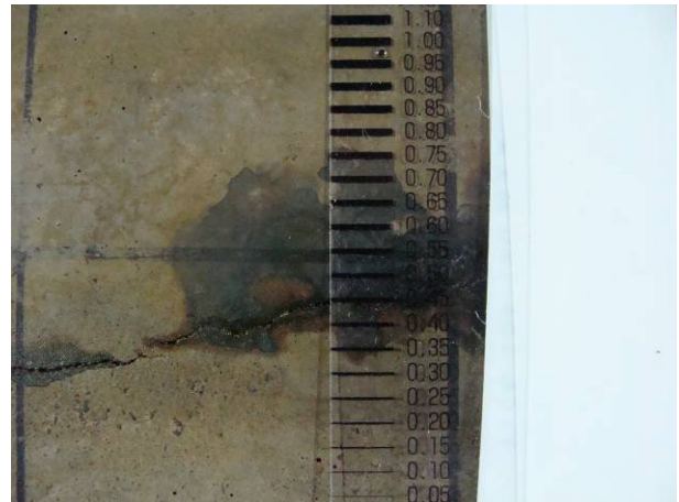
写真-2 ひび割れ幅測定の様子
