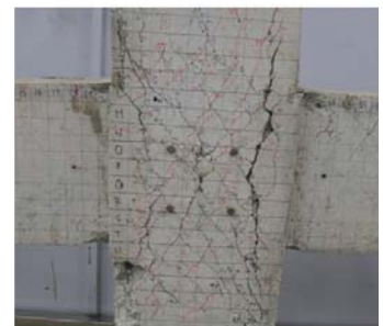
(c) 試験体 No. 3 (鋼板柱筋内側面位置)
