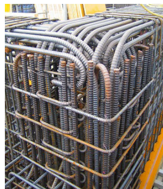
写真-1 配筋状況
