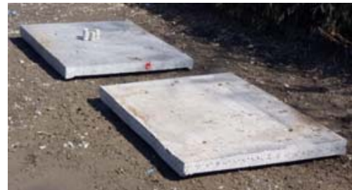
写真-2 切出し床版 (手前: 原床版, 奥: 取替え床版)
