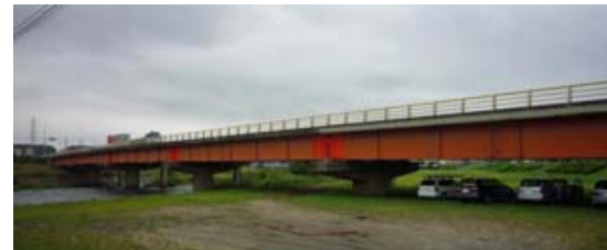
写真-1 対象橋梁全景
