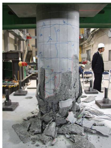
図-6 軸方向鉄筋の座屈による大規模な剥落 (CB-2, 部材角 0.06)
