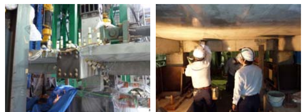
(a) エポキシ樹脂注入作業 (b) PCM 充填作業 写真-1 試験体補修作業の様子
