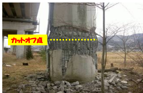
写真-1 地震による橋脚カットオフ点損傷例
