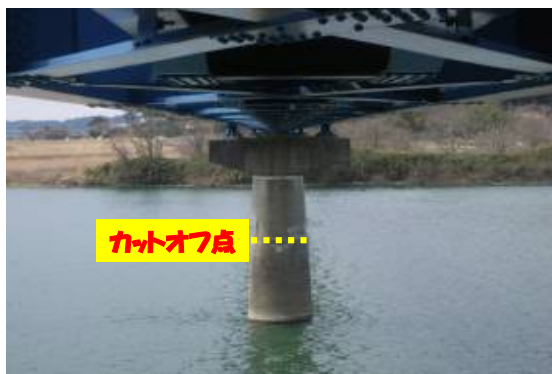
写真-1 地震による橋脚カットオフ点損傷例
