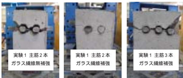
写真 - 1 最終破壊状況 No.3 写真 - 2 最終破壊状況 No.4 写真 - 3 最終破壊状況 No.14
