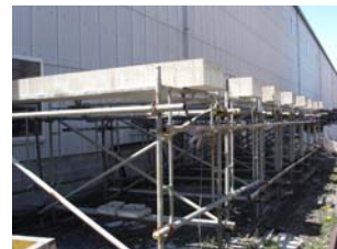
写真-1 防食電流の通電状況
