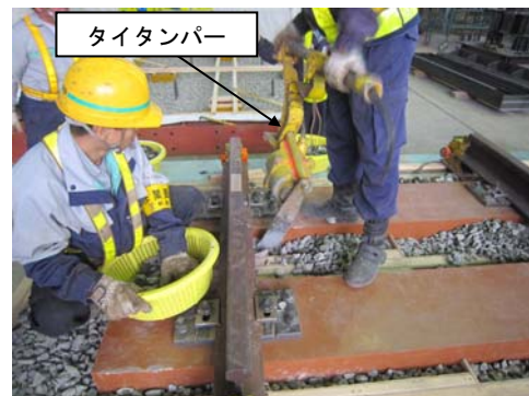
図-2 タイタンパーつき固め試験中状況
