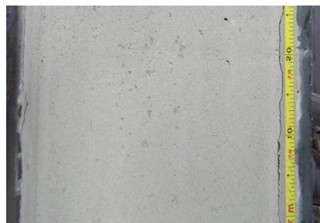
図-13 良好な充填状況 (下り区間)
