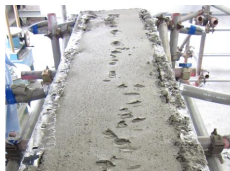
図-5 エア溜りの発生状況
