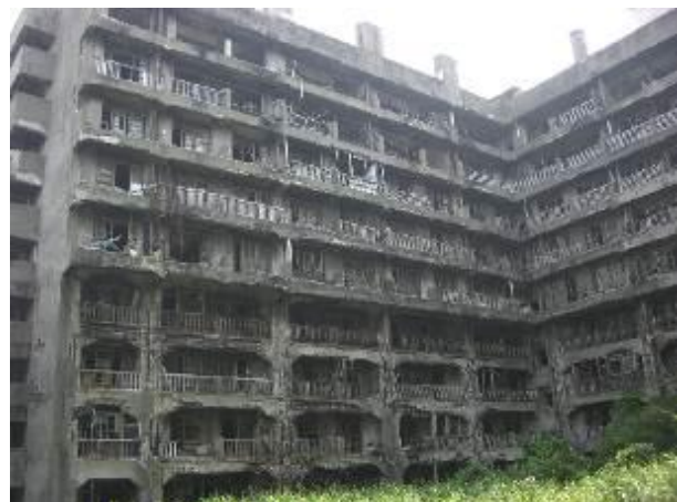
写真-1 65 号棟北棟
