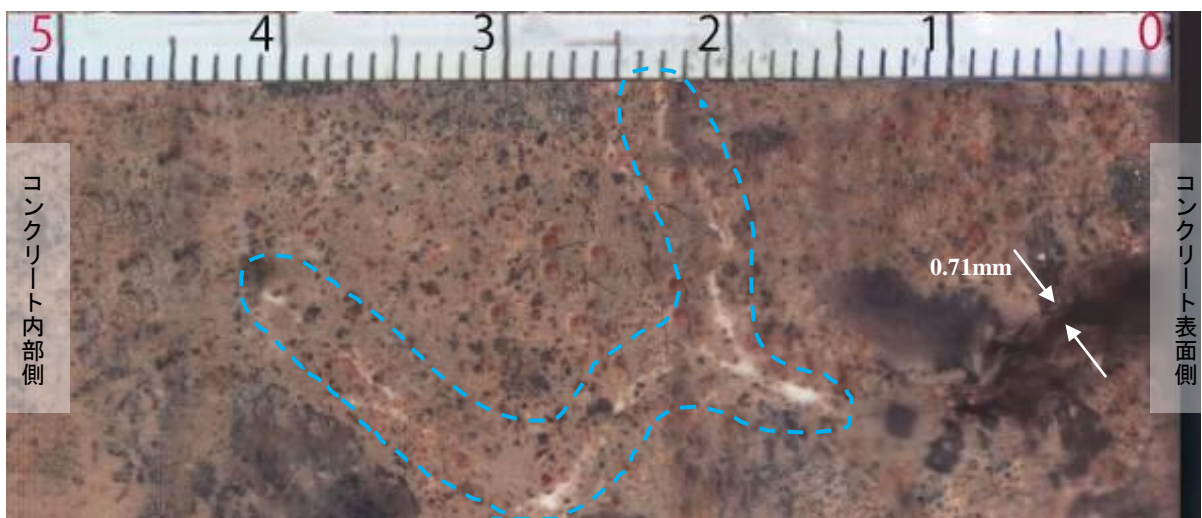
図-8 スキャニング画像の例 (RC ラーメン橋台)
