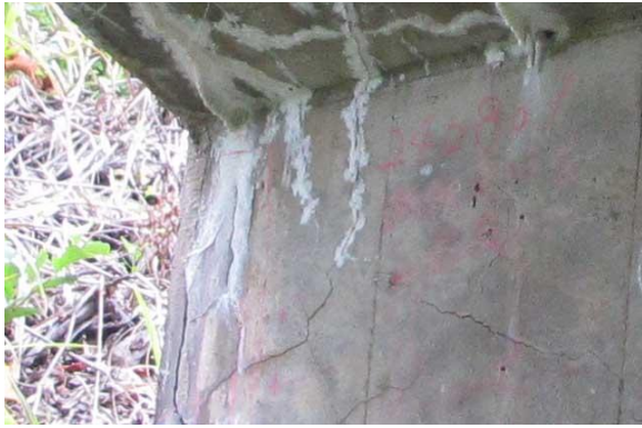
(a) RC ラーメン橋台柱部外観
