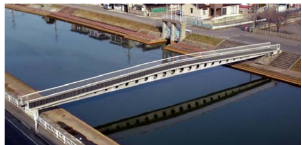
図-1 供用10年が経過した酒田みらい橋
