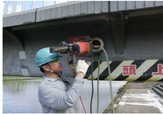
図-3 実橋ウェブからのコア抜きの作業状況
