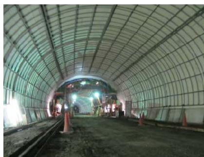
写真-1 養生台車の設置状況
