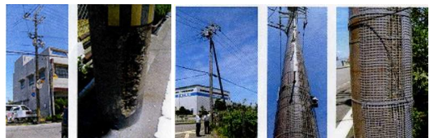
(a) RC電柱 (b) PC電柱
