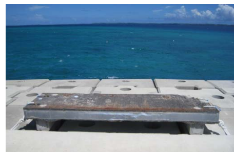
図-1 暴露状況(北東に向かって撮影)
