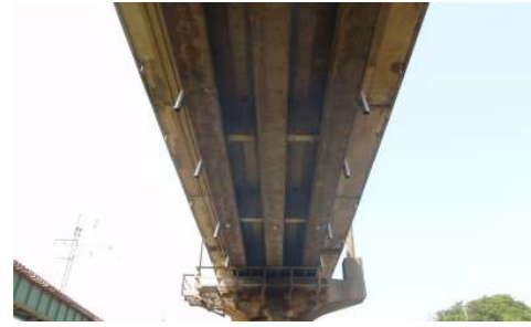
写真-2 チタン溶射施工後外観
