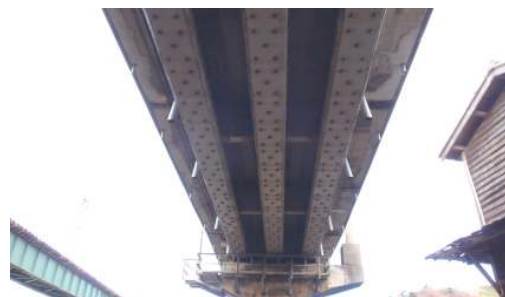
写真-1 亜鉛シート設置後外観
