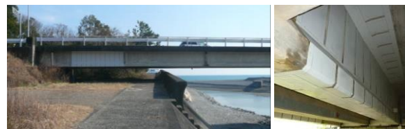
写真-1 試験施工後の状況
