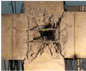
図-4 試験体の破壊状況(層間変形角 7%)
